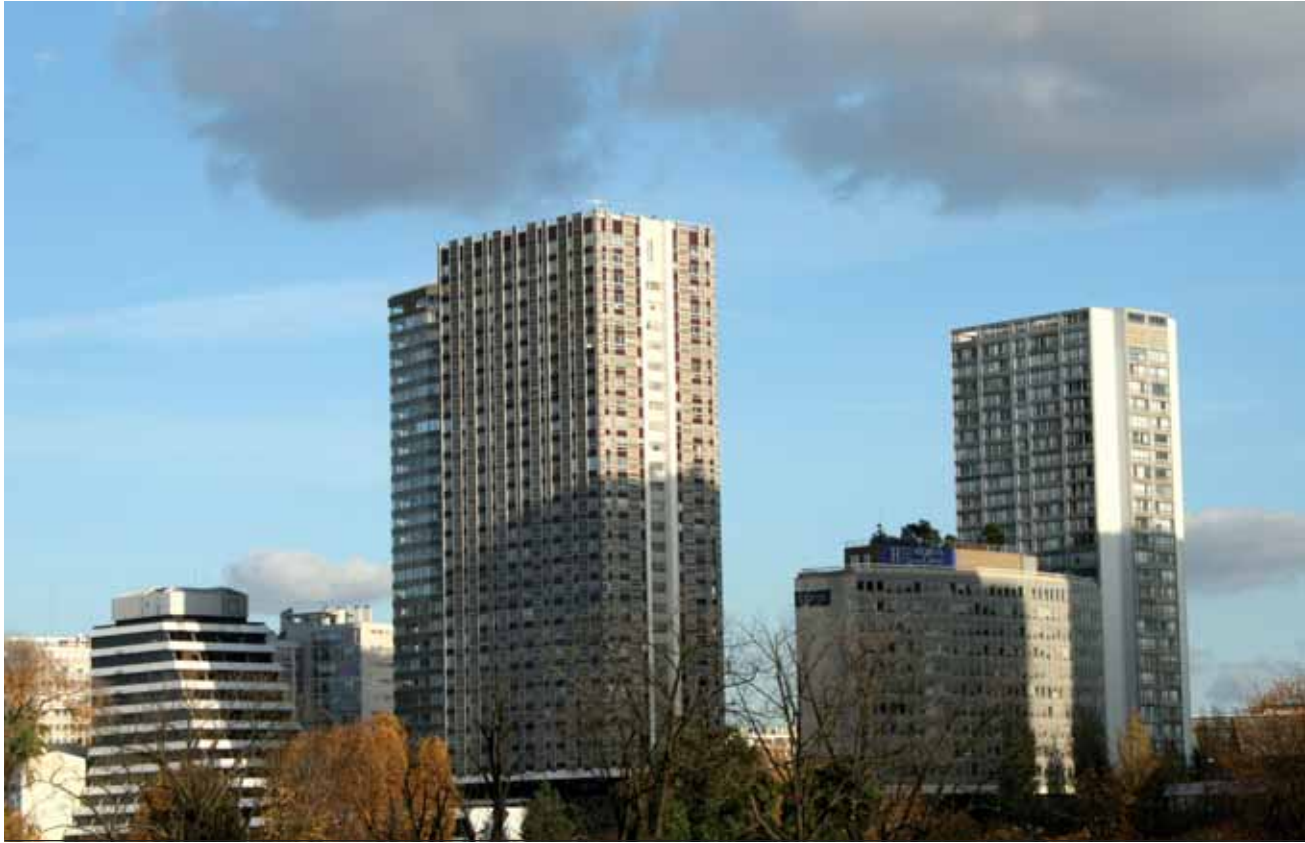
Les IGH des années 70 : un patrimoine qui exige une grande politique de modernisation
